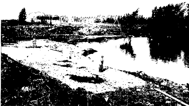
Afb. 2. Er was veel zand nodig voor de aanleg van viaducten in de jaren zestig. De zandzuigput, destijds al gegraven voor de aanleg van de A2, werd weer in gebruik genomen. Door deze uitbreiding werd de pas ontdekte vindplaats bedreigd. Er volgde snel een opgravingscampagne, uitgevoerd door de Rijksdienst voor het Oudheidkundig Bodemonderzoek.
